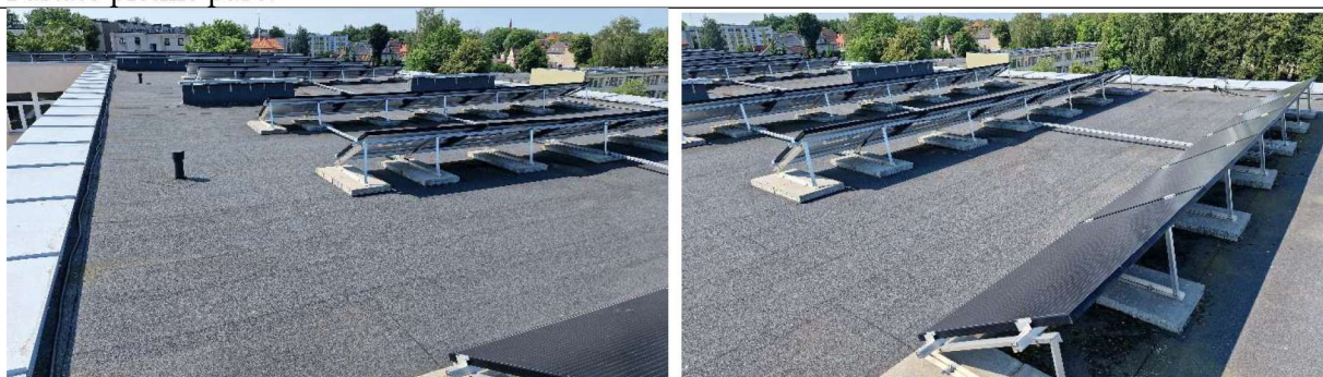
Stogo dalis virš remontuojamų patalpų.
